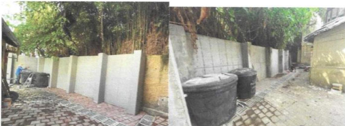
Sobre este punto, realizado el estudio patológico, el perito experto determinó la necesidad de intervención técnica para la reconstrucción completa del tramo del muro afectado, cimentado de manera más profunda y se ejecutaron las obras; se entiende surtido el objeto de experticia en este punto.
